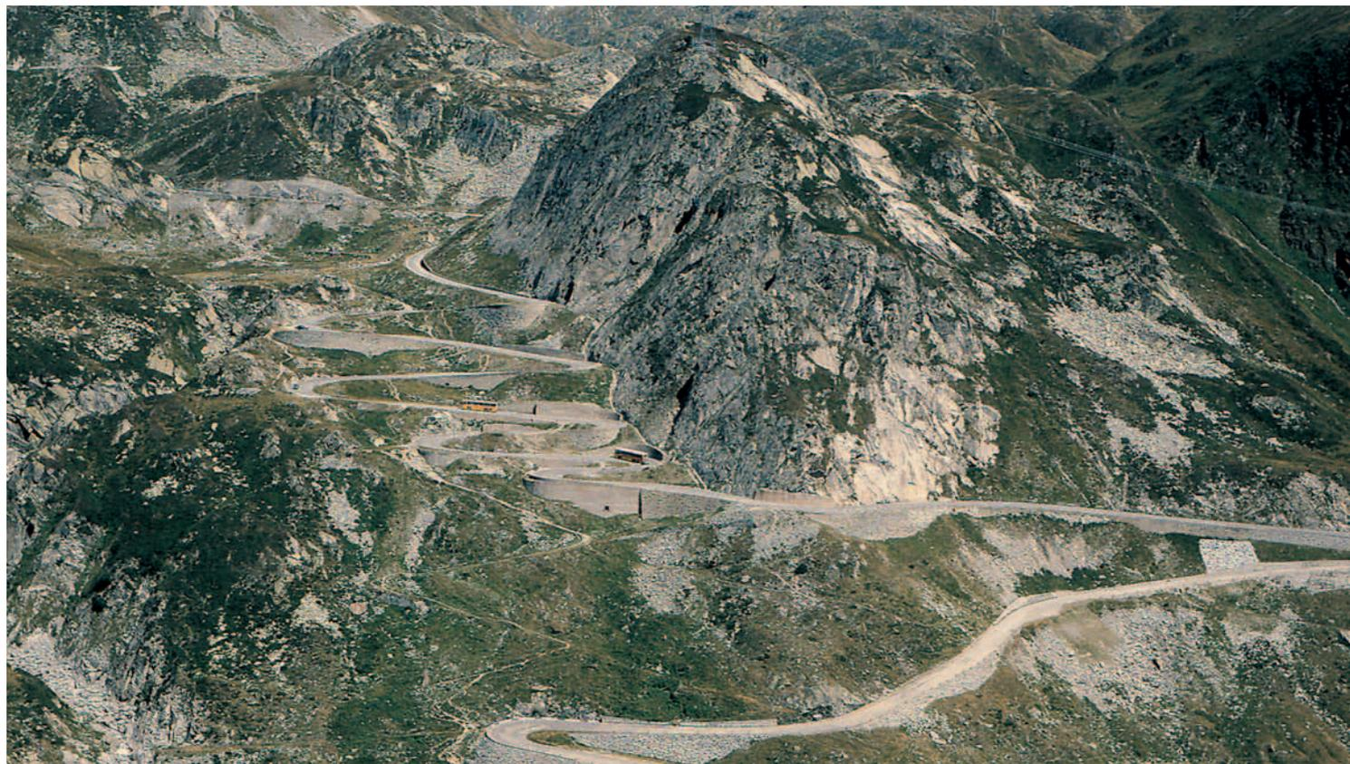
Der Bau der Tremola um 1830 zählt zu den Pionierleistungen des Schweizer Strassenbaus. Die kurvenreiche Strecke ist das Werk des Tessiner Ingenieurs Francesco de Meschini.
